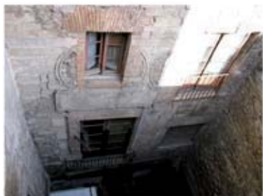
VISTA GENERAL DE LA FAÇANA
