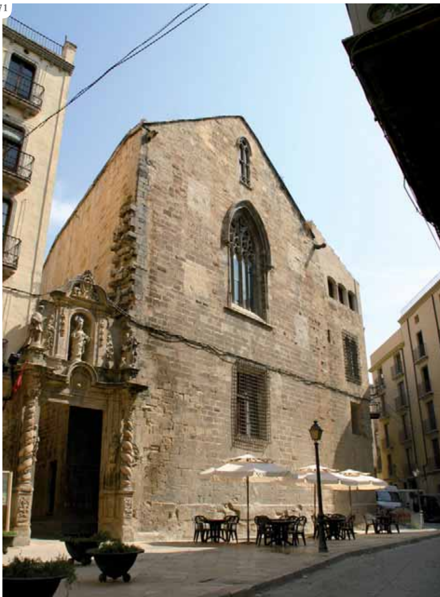
071 Façana meridional del recinte de la catedral. Porta de l'Olivera o de la Cinta, i mur dels edificis del dormitori, de la llibreria i de l'arxiu.
